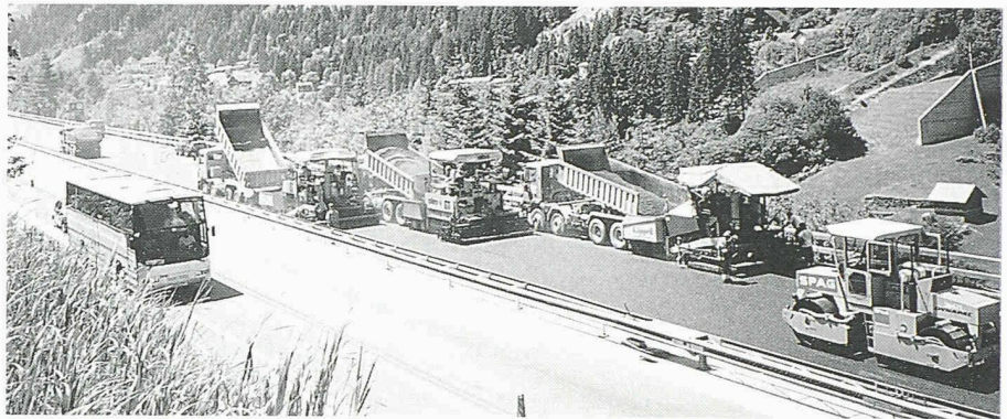
4 Nahtloser Splittmastixeinbau mit drei Einbaumaschinen auf der Spur Romeo
