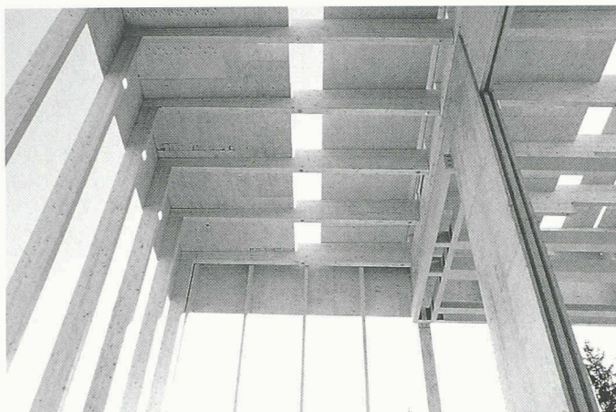
7 Hallendach von innen. Aufnahme während der Montage
