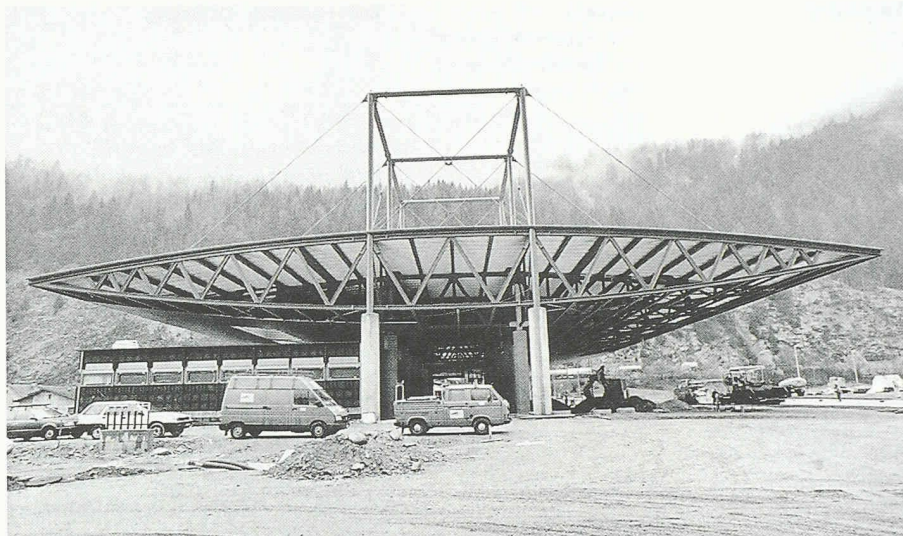
Autobahnraststätte Piotta, Architekt: Mario Botta (Bild: Comet)
