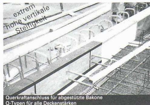
Querkraftanschluss für abgestützte Bakone
