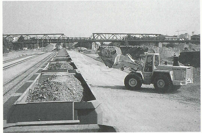
Beladung eines Erdaushubzugs
