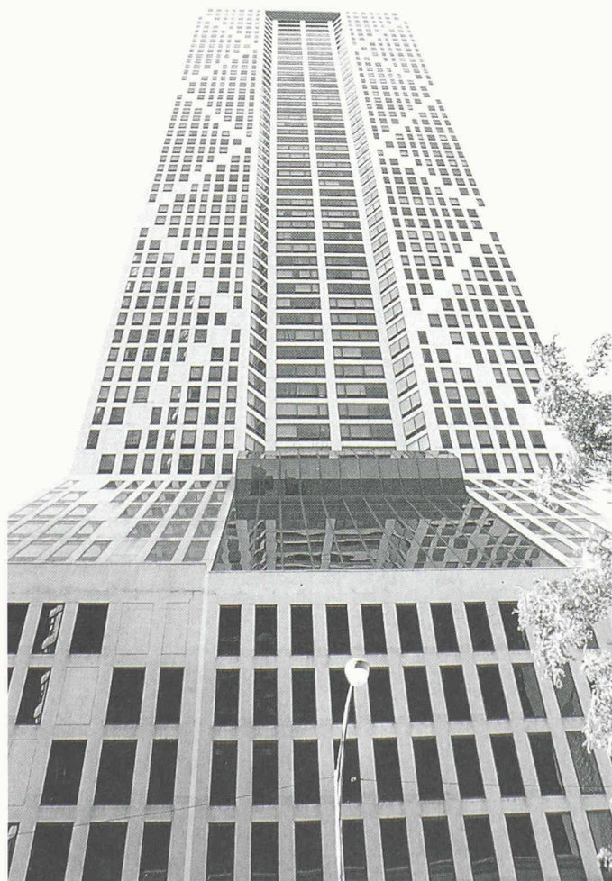
Onterie Center, Chicago (Ingenieur: F. Khan, Architekt: B. Graham, 58 Stockwerke). Die Herausforderung, das Gebäude gegen Windlasten auszusteifen, wurde hier mit innovativen Fachwerkdiazagonalen gelöst. Solche Fachwerkdiazagonalen sind nicht nur wirtschaftlich, sondern bilden auch die Grundlage für ein neues architektonisches Vokabular (Bild: I. Ortega)
