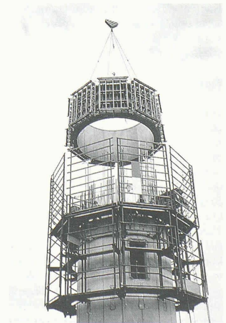
Montage der Turmschalung
