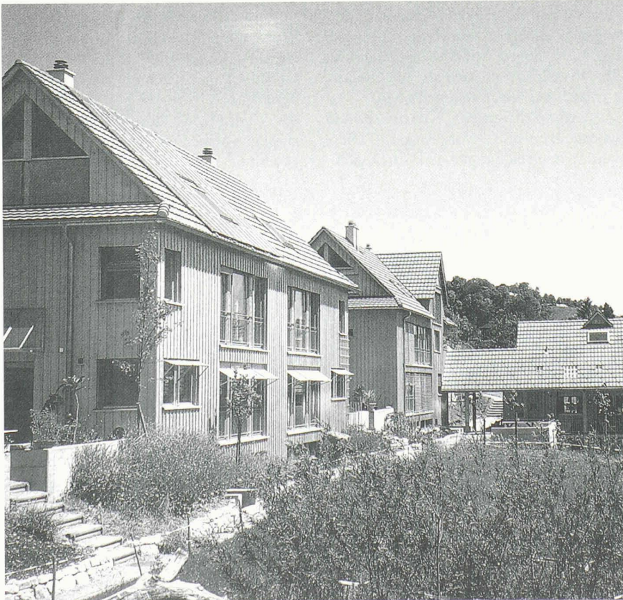
Innenhof der Siedlung Chienbergreben
