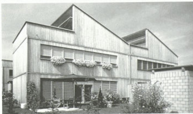
Neubau, Wohnen: Holzbausiedlung Au. Architekten Koeppel & Martinez, Widnau. Erstellungskosten Fr. 2500.-/m 2 HNF
