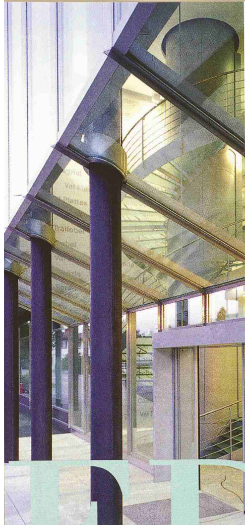
Die dreigeschossige Eingangshalle, transparentes Herzstück des neuen Verwaltungsgebäude der EWBO/OES AG, Illanz. Architekt: Jakob Moutalja, Fotografie: Archiv EWBO.
