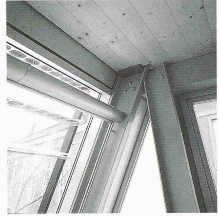
GFK-Profile in der Fassadenebene, Detail Innenansicht
