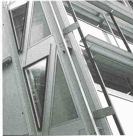
GFK-Profile in der Fassadenebene, Detail Aussenansicht
