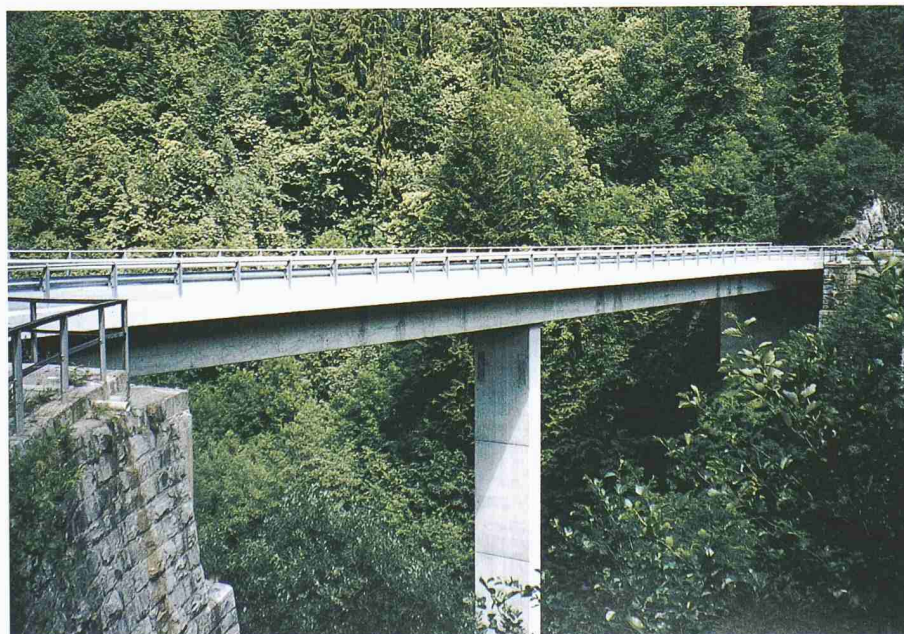
Brücke über den Ri di Verdasio, Ansicht
