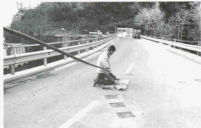
9 Einziehen der Karbonkabel in den Kasten (Bild: Empa)
