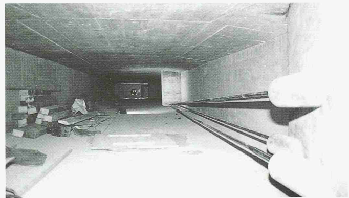
8 Externe Karbon-Vorspannung im Widerlagerbereich Seite Camedo
