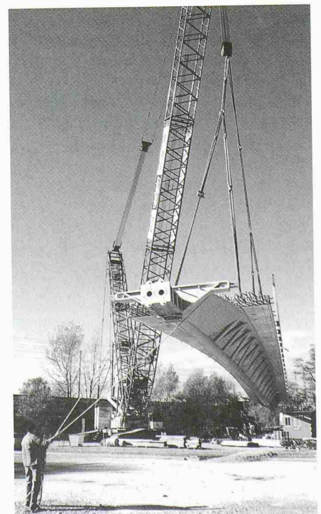
5 Montage mit Raupenkran
