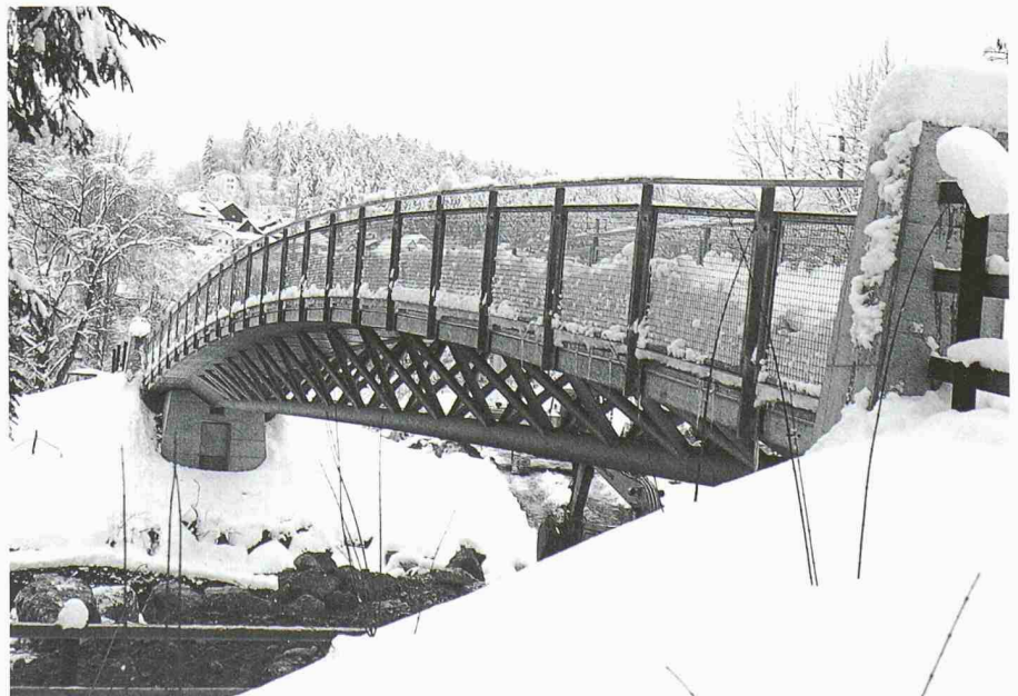
1 Ansicht der Brücke vom nördlichen Widerlager aus
