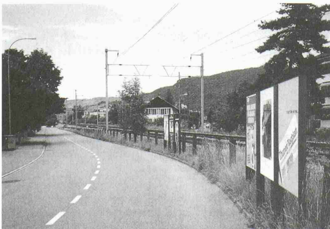
Parallele Lage von Bahn und Strasse an der Schorenstrasse in Thun
