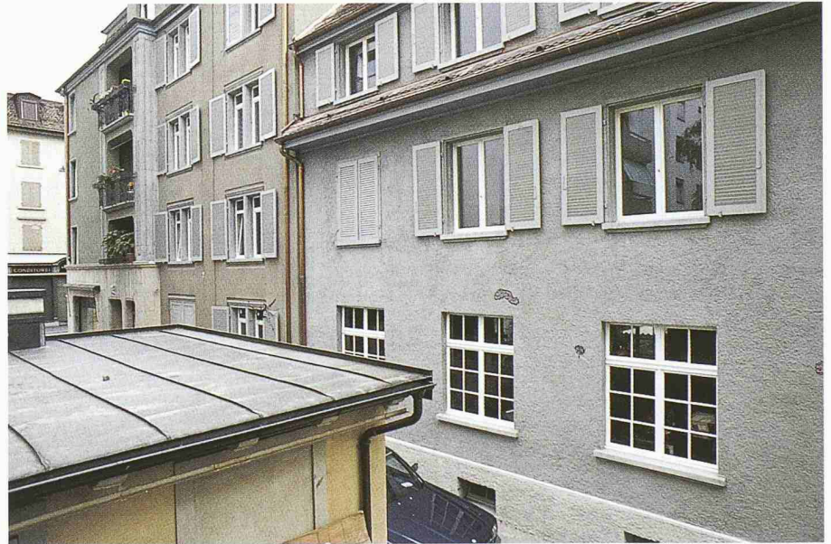
Sanierung Seefeldstrasse 172, Zürich. Alter Zustand links oben, Sanierter Putz unten. Farblich unterschieden sind zudem das Vorder- und das Hinterhaus
