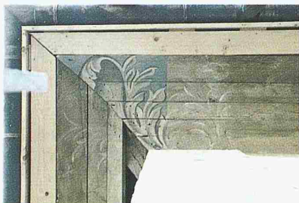
Dachuntersicht mit retuschierten Originalpartien
