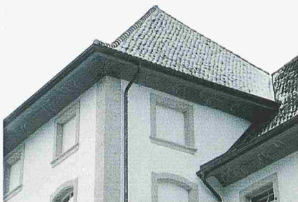
Dachuntersicht beim renovierten Konvent an der Südfassade
