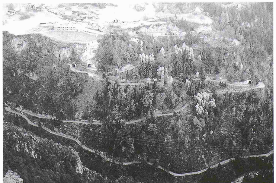
Luftbild der südlichen Talflanke des Maderanertals mit dem untersuchten Abschnitt der Bristenstrasse zwischen Amsteg (rechts) und St. Antoni (oben links)
