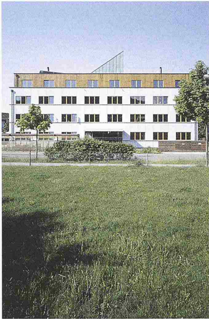
2 Haus Focus: Ansicht von Nordosten
