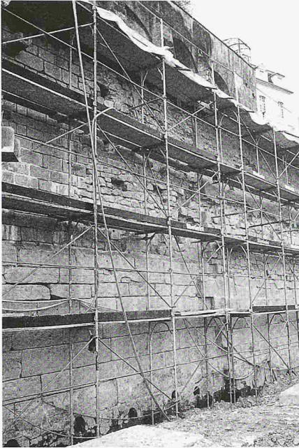
Instandsetzung der vorderen Ufermauer. Die Nischen der Nagellage 1, 3, 4 und 5 sind noch offen. Lage 2 ist bereits verschlossen
