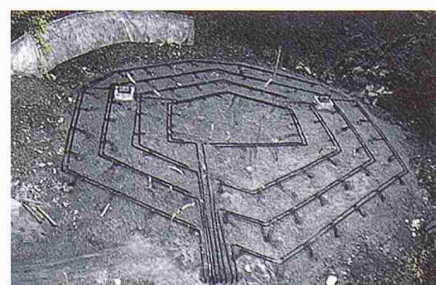
2 Aufsicht auf ein Feld von vertikalen Erdwärmesonden, wie sie prinzipiell zum Einsatz kämen
