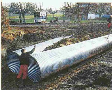
Montage eines HAMCO-Wellstahlrohres in Ermensee, Kt. Luzern.
