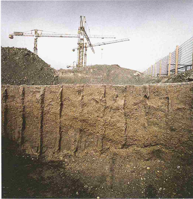
6 Im Mai 1992 in Regensdorf erstellte und mit Eisenoxid eingefärbte Schmaldichtwand, die zur Kontrolle freigelegt wurde
