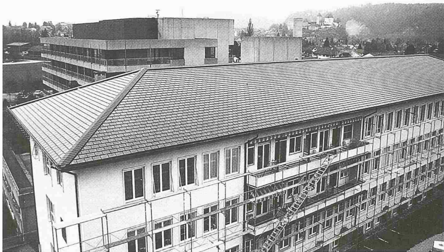
Vollflächig mit unauffälligem, leicht blauem Solarschiefer gedecktes Dach des Spitals Burgdorf
