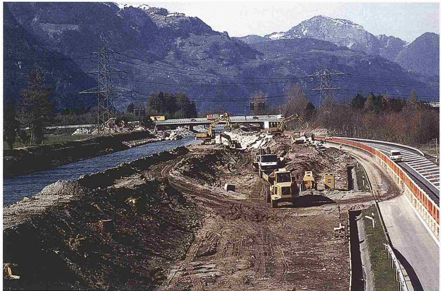
Verschiebung des Reussdammes (Bild: Irène Elber)
