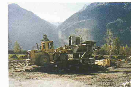
3 Einbau der tonwassergebundenen Deckschicht beim Wuhrweg
