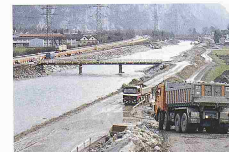
1 Konzentrierte Blocksatzarbeiten am linken Ufer in Attinghausen
