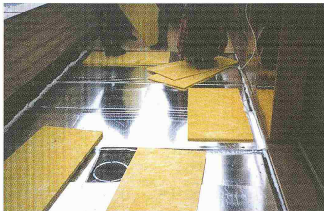
Passivhaus in Wolfurth mit VIP-gedämmter Dachterrasse
