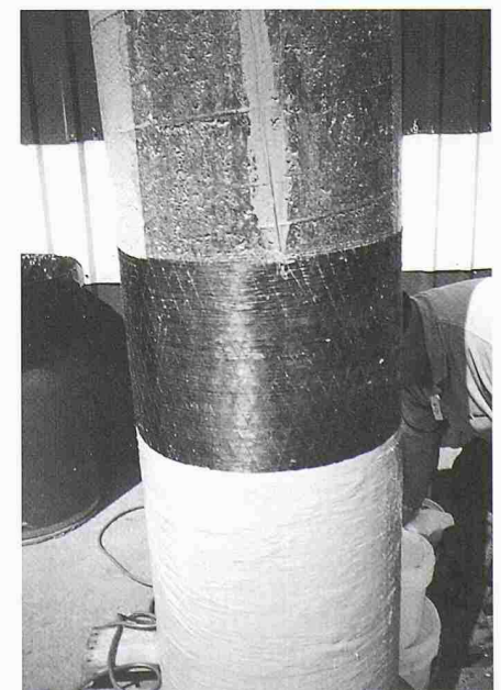
11 Mit Karbontüchern umwickelte Rundstütze
