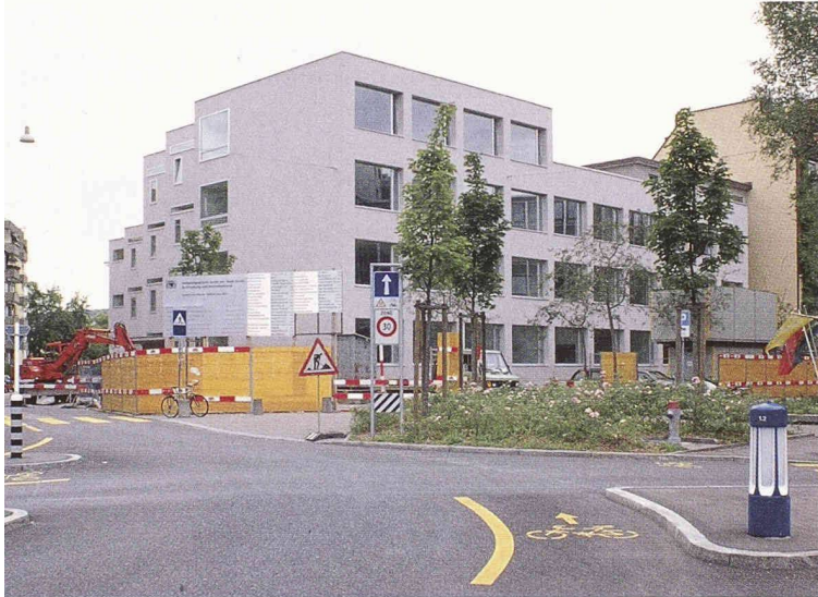
Die Heilpädagogische Schule an der Gotthelfstrasse in Zürich hat nach der Sanierung als erste städtische Liegenschaft das Minergie-Label erhalten (Bild: pd)
