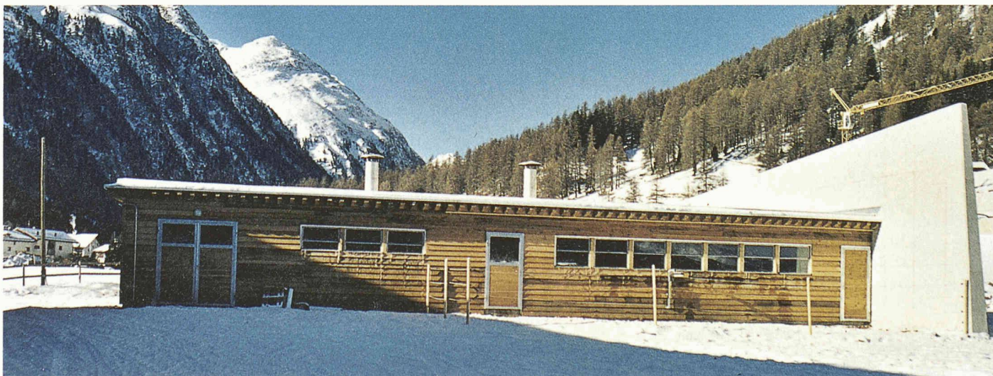
Unverhüllte Tatsachen: Schutzmauer eines Stalles in Bever (Architekt: Buolf Vital)
