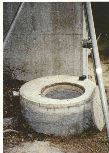
Die Pfeilerschächte der Brücken wurden visuell inspiziert. Die Deckel werden durch abschliessbare ersetzt
