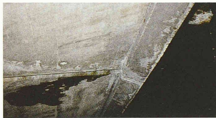
Die Dachentwässerung einer Galerie weist einen konstruktiven Mangel auf, so dass aufgestautes Wasser durch die Dilatationsfugen an die Untersicht gelangt
