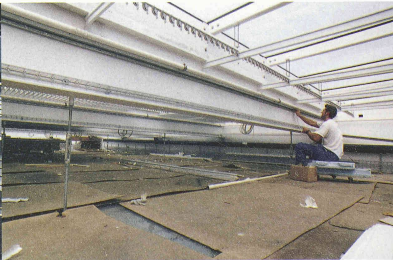
12 Raum zwischen Dachhaut und begehbaren Glasdecke, darunter als dritte Schicht die Staubdecke
