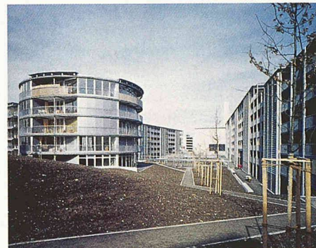
Die Genossenschaftssiedlung Regina-Kägi-Hof wurde von Theo Hotz für die Allgemeine Baugenossenschaft Zürich (ABZ) geplant. Sie bietet preisgünstige, geräumige Wohnungen (unten) (Bild: Allreal)
