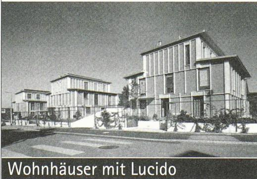
An diesen Wohnhäusern konnte erstmals die lichtaktive Gebäudehülle Lucido angewendet werden. Dieses Fassadensystem nutzt die Solarstrahlung für die Aufrechterhaltung der inneren Wärme, was bedeutet, dass der U-Wert sehr tief ist. Lucido, ein Holzabsorber geschützt hinter Glas, fängt das Licht ein, speichert die Wärme und schützt vor Wärmeverlust von innen nach aussen.
