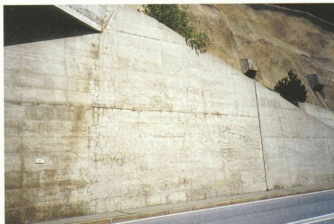
Stützmauer Kt. Wallis: AAR-Risse, die im wetterexponierten Bereich gut erkennbar sind
