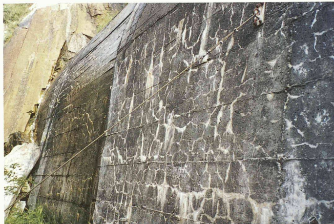
Galerie Kt. Bern: typisches AAR-Rissmuster mit Kalkablagerungen
