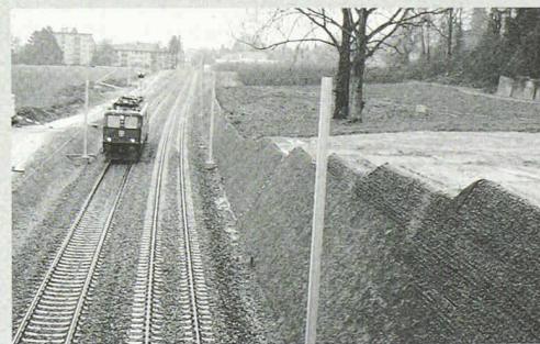
60° Steil- böschung neue Doppelspur MTHB Kreuzlingen.
