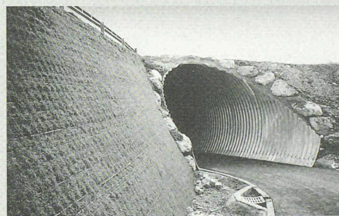
Geh- und Radweg- unterführung Staatsstrasse Nr. 13 Wil-Wattwil
