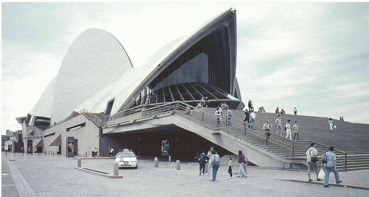
Einstieg in die Treppenanlage mit darunter liegender Autozufahrt
