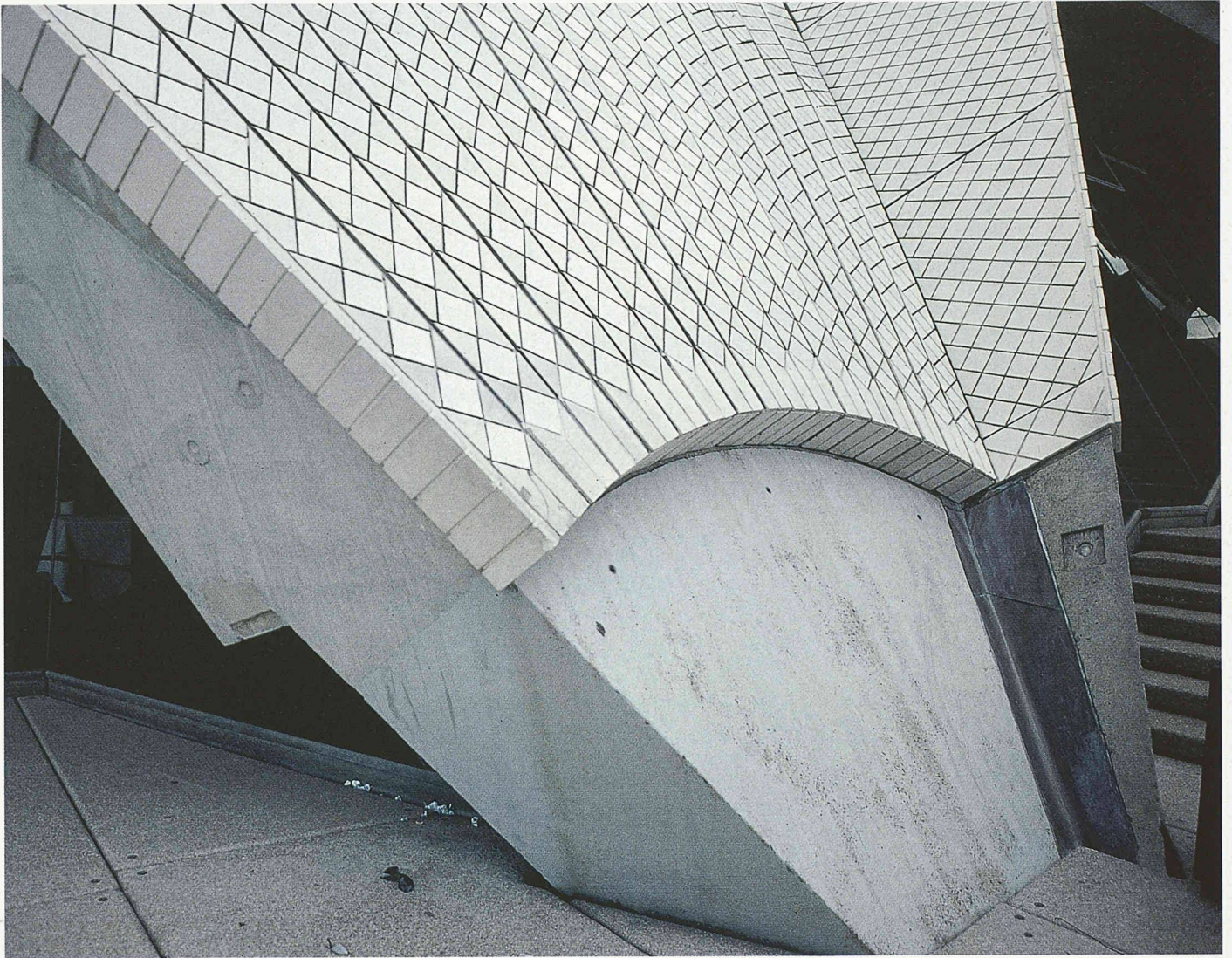
Das Weiss der Schalen wird von Abertausenden von Keramikkacheln gebildet, die aus Schweden importiert wurden
