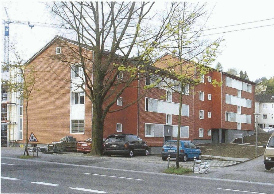
Siedlung Wehntalerstrasse Nr. 475–501: Aussenverkleidung mit Holz-Stulpschalung (Bilder pd)
