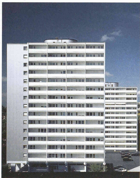
Die drei Hochhäuser «Parc de la Rouvraie» in Lausanne: saniert und mit rund 8500 m 2 Aluminiumplatten verkleidet (Bild: pd)
