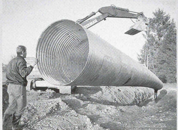
Montage eines HAMCO-Wellstahlrohres in Ermensee, Kt. Luzern.
