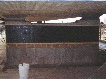
Ponte Cebbia A13: Umschnürung der Brückenaufleger mit S&P C-Sheet Schweiz
