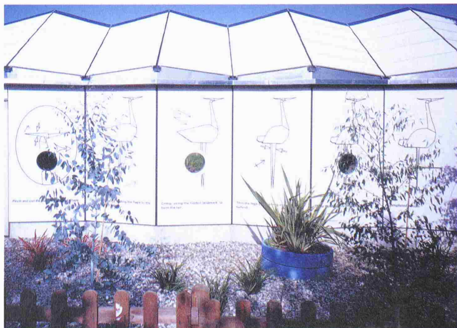
9-11 Kartonpaneele, imprägniert und beschichtet für Fassade und Dach; gefaltetes Dach und Fallfiguren als Fassadenornament
