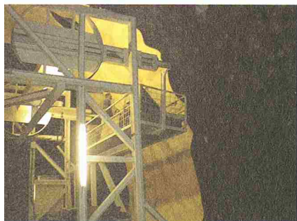
Kletthaftsystem von Sarnafil im Gamsen-Tunnel
