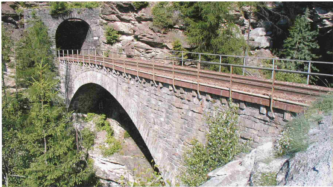
Ansicht vom Widerlager Seite Bernina. Die Anhebung des Bogens in Brückenmitte infolge mit dem Hang talwärts rutschender Widerlager ist deutlich erkennbar
