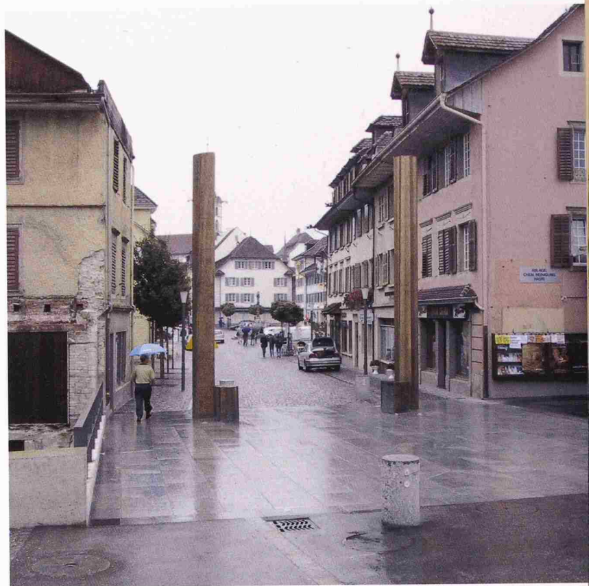
1 Flankierende Massnahmen im Städtchen Sursee LU. Blick vom Obertor in die Altstadt nach der Umgestaltung des Strassenraumes. Das Skulpturenpaar markiert an Stelle des abgebrochenen Obertors den Eingang zur Altstadt (Bild: Metron)
