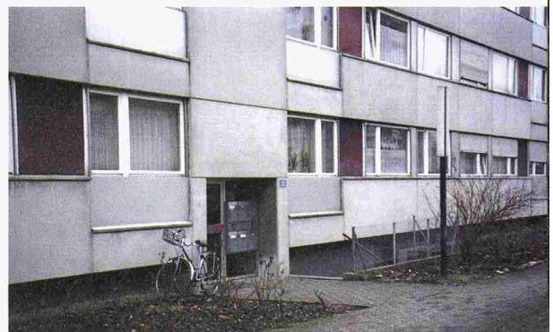
Siedlung Surinam, Basel, ursprüngliches Baujahr 1971. Architekten Suter und Suter, Sanierung Hartmann und Stula. Zustand jeweils vor und nach der Sanierung 1997-99 (Bilder: Lilli Kehl, Basel)
