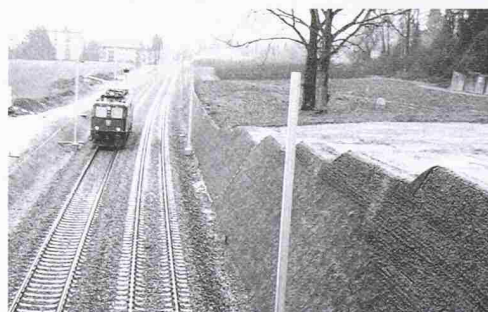
60° Steilböschung neue Doppelspur MThB Kreuzlingen.
