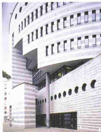
Eingangsbereich mit Schleuderbetonstützen; Botha-Haus, UBS in Basel (Bild: Varinorm)
