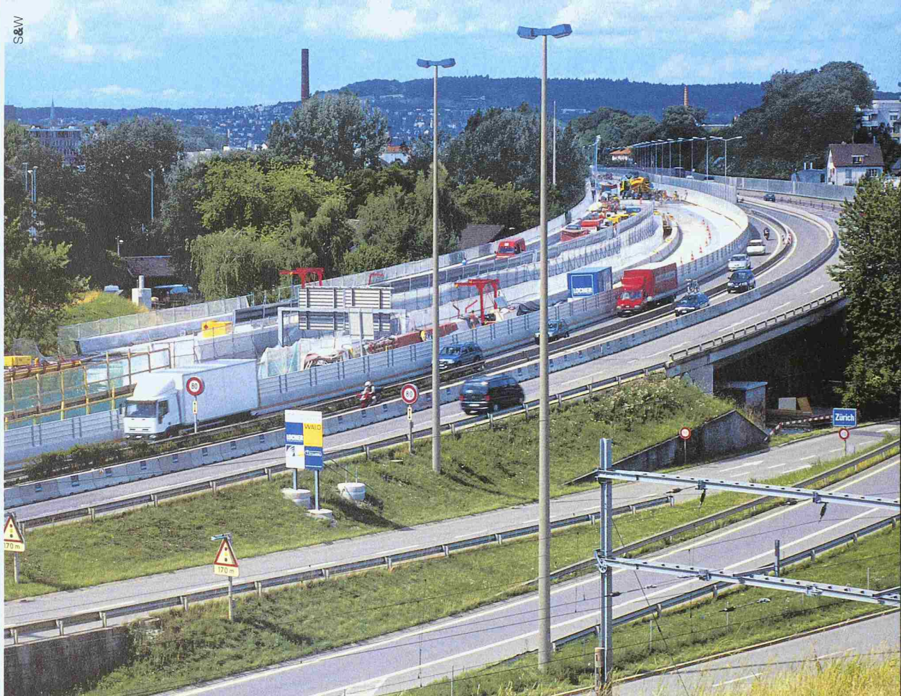
ARGE Sihlhochstrasse, Zürich. Grösste umfassende Brücken-Instandsetzung in der Schweiz
