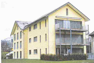
Überbauung Ziel in Appenzell; Fassade: System Outdoor-Top
