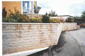
Garten- und Stützmauer Leromur
