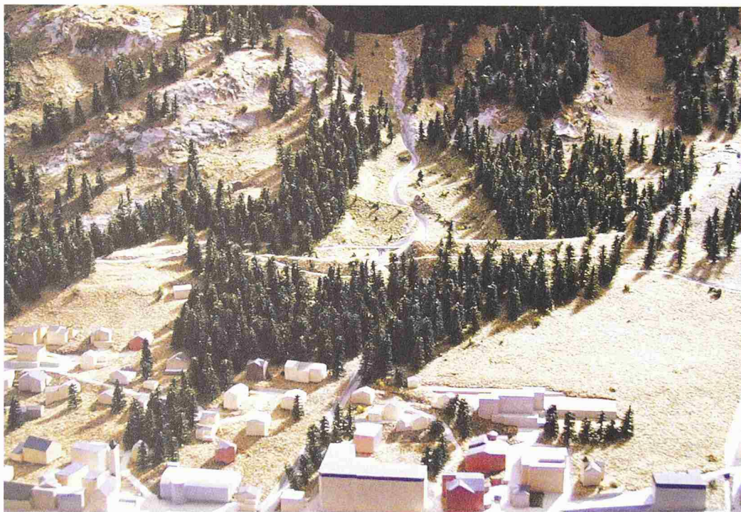
Modell des Schutzbauwerkes. Hinter dem Waldstreifen sind die Dämme erkennbar, weiter oben die Vordämme (Bild: Hans Rigendinger)
